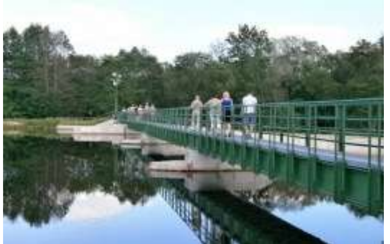
Gājēju tilts pār Aivieksti.
