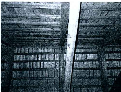
Attēls Nr. 17 – jumta pieslēgums pie izbūves bez skārda atloka;
