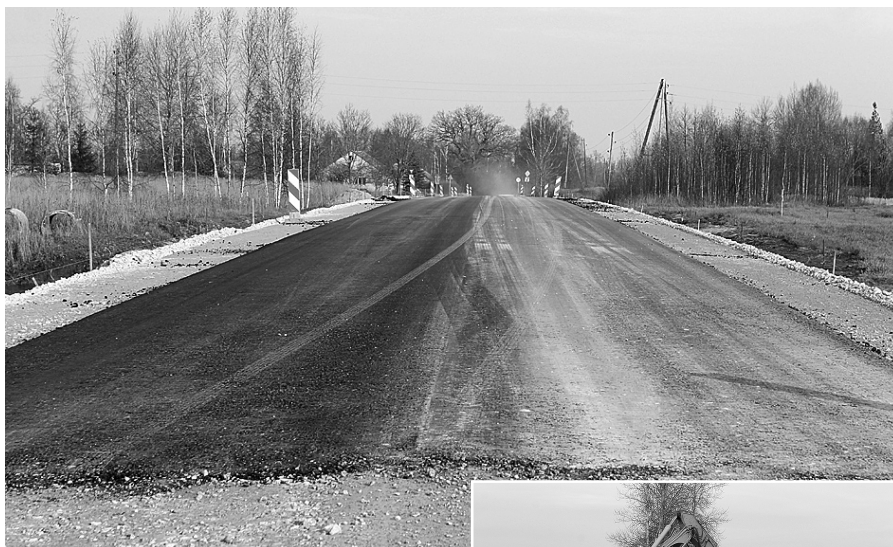
Pirmais asfalta posms pie „Dimantiem”.
