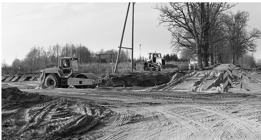
Ceļa remontdarbi Ozolkalnā.
