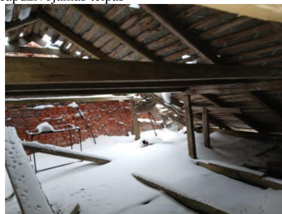
15., 16.attēls. Ēkas bēniņi (jumta bojājumi)
